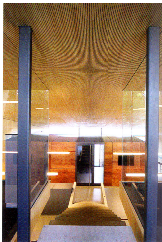
Die Gestaltung von Wänden und Decken erfolgte über eine dezent strukturierte Verkleidung aus Weißtanne
