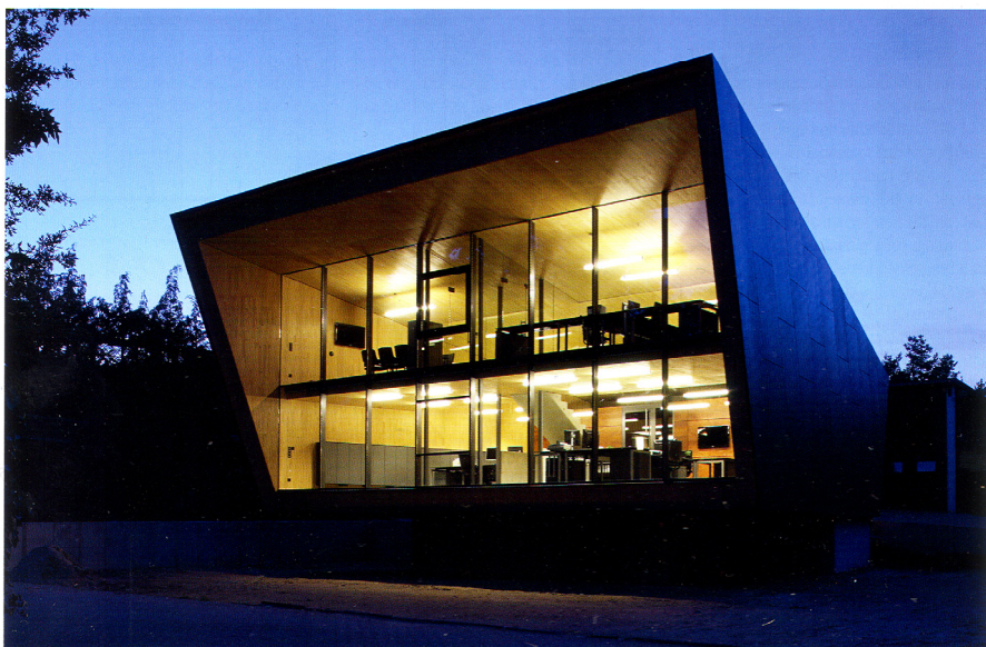
Die Außenhaut des Gebäudes besteht aus großformatigen anthrazitfarbenen Faserzementplatten, die das gesamte Gebäude umhüllen. Im Sommer dienen sie als eine Art Abstrahlschicht
