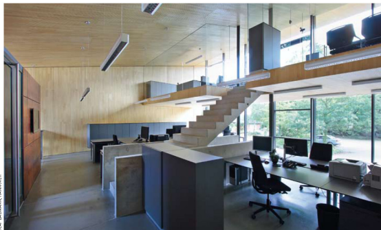
▲ Die in die Decke integrierten Akustikmodule reduzieren den Geräuschpegel trotz der Größe des Raums und der Glasflächen auf ein angenehmes Maß
