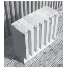
Brettstapelwände sind massive Elemente aus gewöhnlichen Brettern, die vertikal angeordnet und genagelt die primär tragende Struktur von Wänden, Decken und Dächern bilden können.
