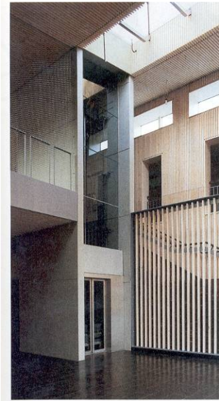
Nur wenige Gebäudeteile wie der Aufzugschacht in der Eingangshalle und die Geschosdecke des Verwaltungstrakts sind aus Beton. Auf der Galerie links im Bild dient ein filigranes, bis zur Decke gespanntes Stahlnetz als Absturzicherung.
