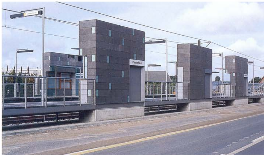
Gesamtansicht der Haltestellenblöcke aus MENDINGER BASALTlava
