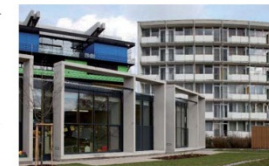
2 Um den grünen, von Flora und Fauna bestimmten Campus durch den Neubau möglichst wenig zu beeinträchtigen, ist die Kita nach grundlegender Standortanalyse südlich eines Bettenhauses aus den 1970er Jahren und eines Laborgebäudes aus dem Jahr 2005 platziert. Die Zugänglichkeit erfolgt von Osten und nutzt synergetisch die bestehende Infrastruktur der beiden existierenden Bauten.
