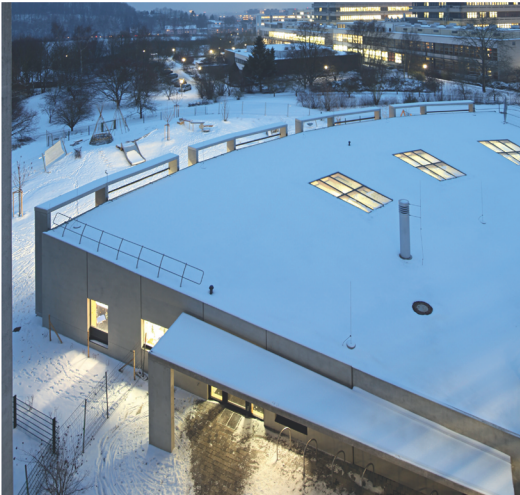
Die Vorteile der Passivbauweise zeigten sich besonders beim winterlichen Wärmeschutz.
