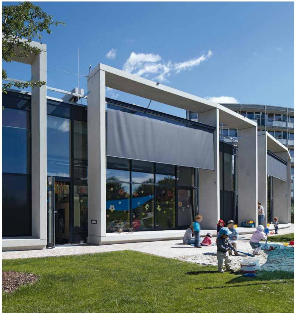
11 Die Weiterführung der Innenwände bilden in der Ansicht überdimensionierte Bilderrahmen. Der untere Bereich fungiert als Sitzbank, Ballustrade und Leitgeländer, der obere Abschluss als Träger eines dynamischen Sonnenschutzes. The extensions to the interior walls form oversized picture frames. The bottom area serves as an alcove for sitting on, a balustrade and a parapet, while the top area supports a dynamic sunshading system.
