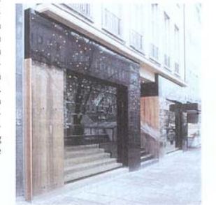
Markantestes Element der Umgestaltung des Cafés Kreipe zum Modegeschäft sind die zwei schwarzen »Natursteinbügel« aus poliertem NERO ASSOLUTO, die rechts und links des Haupteinganges die beiden Nebeneingänge säumen. Sie sind aus 40 mm dicken, vorge-setzten Platten mit versetzten offenen Fugen, sichtbar vorgehängt um die stählerne Hauptkonstruktion gefügt. Tektonisch wird durch die »Balance« der Bügel auf liegenden, sich mit dem Naturstein verschränkenden Holzbügeln die monolithische Natursteindominanz zugunsten eines assemblagehaften Wechselspiel im Dreiklang mit Holz und Glas aufgelöst. (Fotos: Despang Architekten)
