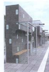
Mit Basaltlava hat das Büro Despang Architekten, Hannover, die Bahnsteige und Warteblöcke der Haltestelle Pressehaus der Expo-Hochbahnsteige bekleidet. Besonderheit: oberflächenbündig in die Natursteinbekleidung eingesetzte Glasintarsien, die nachts durchleuchtet werden.
