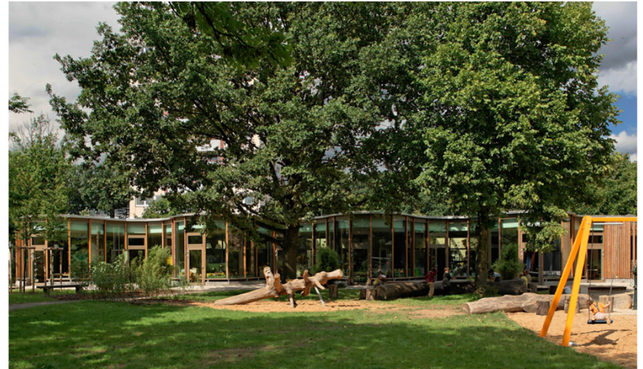
Abb. 5.1.01 Großzügige Verglasung nach Süden
