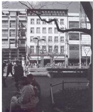
Zustand vor dem Umbau
