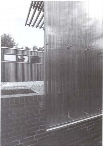
Makrolon-Stegplatten schützen den Freisitz vor Wind und Regen
